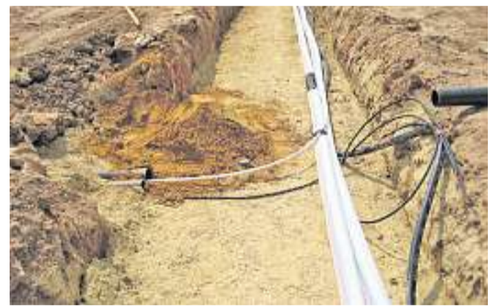
So sieht die Verlegung der Leerkannülen (nach links) im Wörter Baugelände aus, in die später die Fiber-to-the-home-Glasfaserkabel eingebracht werden können. (Foto: ODR TSG)
